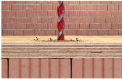
Bohren der Materialkombination Holz und Mauerwerk
