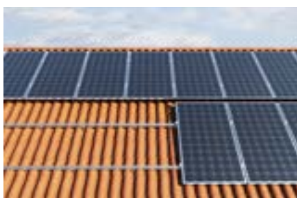
Steildach mit Ziegel-Eindeckung
