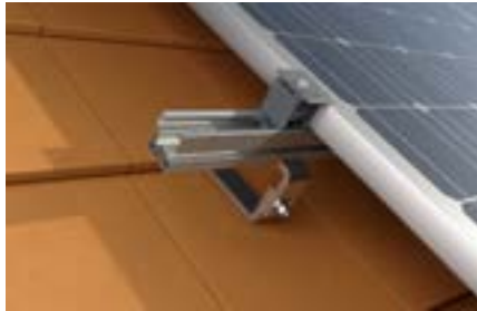
Steildach mit Flachziegel-Eindeckung
