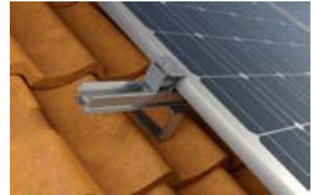
Steildach mit Ziegel-Eindeckung
