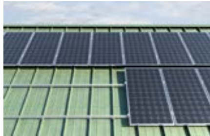
Steildächer mit Rundstehfalzblech-Eindeckung
