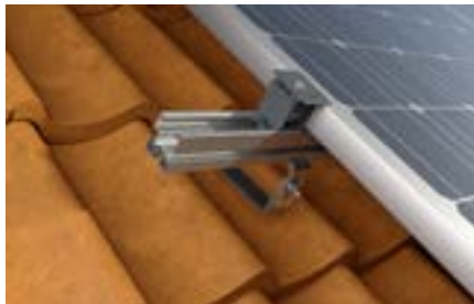
Steildach mit Ziegel-Eindeckung
