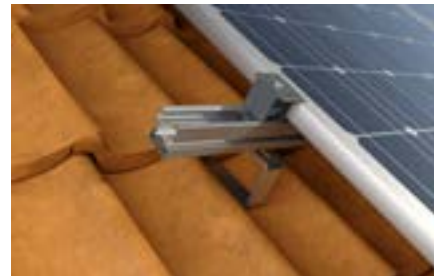
Steildach mit Ziegel-Eindeckung
