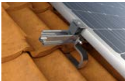
Steildach mit Ziegel-Eindeckung
