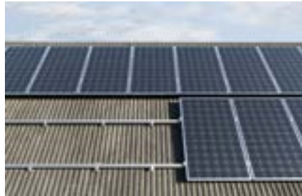
Steildach mit Wellblecheindeckung
