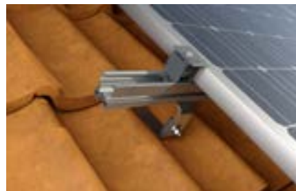
Steildach mit Ziegel-Eindeckung
