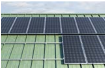
Steildächer mit Stehfalzblech-Eindeckung
