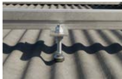
Befestigung an Faserzementplatten
