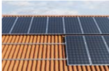
Steildach mit Ziegel-Eindeckung
