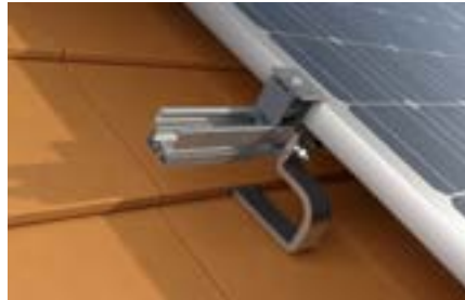
Steildach mit Flachziegel-Eindeckung
