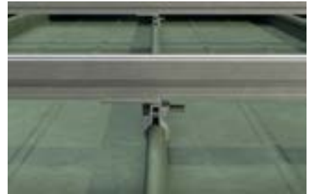
Montage am Rundstehfalz
