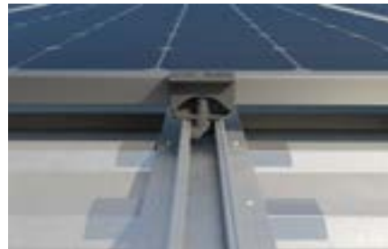
Befestigung an Trapezblechdachsystemen
