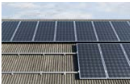
Steildach mit Wellblecheindeckung
